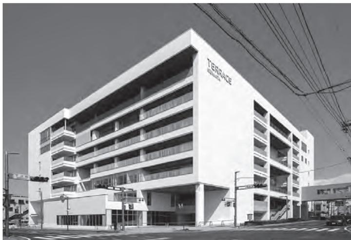
テラス沼田は1993年3月に竣工した大型商業施設を、減築という手法を用いて市役所にコンバージョンした建築である。
