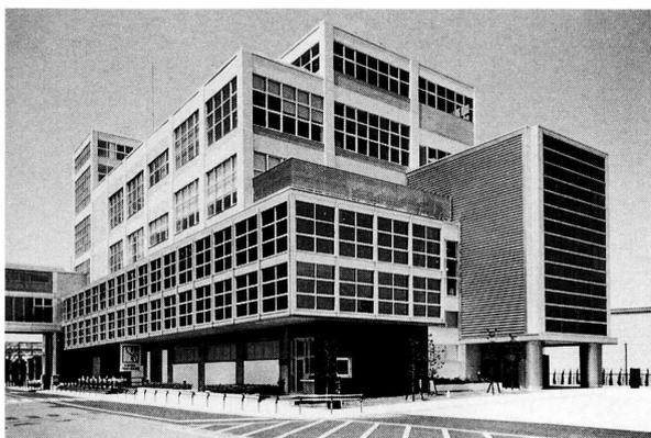
この施設は、1962年（S37年）にビール工場の仕込棟として建築された。35年後の1997年（H9年）に、機能とプログラムを変更し、新しくできたハイテク工場と渡り廊下でつながりながら、この棟を訪れた工場見学者や地域の人々にビールの歴史と文化に触れながら憩える場に仕立て直している。「ビア・パーク」という名称で「レトロとハイテク」を実感できるよう計画され、社会に開かれた親しみのある施設に変貌した。レストランを併設した見学者受入施設と事務所・従業員の構成施設等の異なる機能を収めながら、明快な動線処理によってそれらを分離している。工場施設だったこの建物に耐震壁、ブレースの新設、柱の打ち増しという耐震補強をしながら、躯体と天井の高い空間を生かし、外装はスチールサッシからアルミ・カーテンウォールに改修している。あわせて垣根を撤去し、公開空道を創り出して緑化を行い、地域景観の向上に寄与させていることは大いに評価できる。
