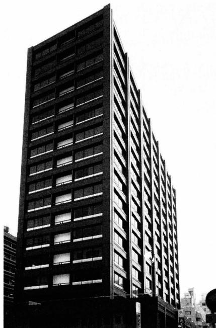
〈審査評〉 ディックビルは、昭和35年（1960）、大日本インキ化学工業の本社ビルとして計画が開始され、昭和42年に竣工した地上18階、地下5階の建築である。いろいろのものが発展した高度成長期のこの時代、建築および都市計画の分野でも、さまざまな新しい技術が研究され、開発されたが、ディックビルは、この時期に生まれた新しい構想や技術を一挙に総合化し、一体にしたようなビルであった。例えば、柔構造による純鉄骨構造の超高層ビルであり、ロングスパンラーメンのオフィス空間は、1.5 m をモジュールとして、フレキシブルな空間
