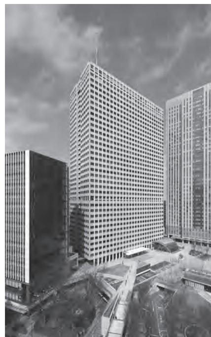
霞が関ビルは1968年、日本初の超高層ビル(100m超)として竣工し、2018年に50年目を迎えた。1994年(平成6年)にはBELCA賞のベストリフォーム部門を受賞している。建設にあたっては、様々な新しい発想と工夫が行われ、柔構造理論を採用した初の耐震構造物であったが、大型肉厚H型钢の採用、内装のモジュラーコーディネーション、トイレの床上配管に代表される徹底した設備のユニット化、自動制御運転管理や記録保存等々の技術は、その後の数々の超高層ビル建設の一般技術として継承されていった。
