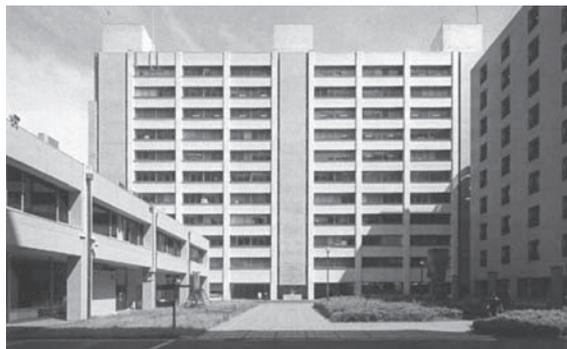
東工大すずかけ台キャンパスは、学部機能を持たない我が国初の大学院大学創設を目標として、1970年代後半から実質的な運用を開始した。当G3棟は、初期マスタープランに基づき当時の建築学科の助教授であった谷口汎邦（現東工大名誉教授）を中心とする長津田研究室により設計された高層研究棟のひとつで、モダニズム建築の流れを汲むものであった。緑豊かな丘陵地の外部風景を満喫させる横連装の、2つのオフィス空間（メインボディ）が、3mセットバックした縦シャフトで連結されるという明快な構成であった。耐震改修が喫緊の問題となり、併せて当初はセントラル空調であったが、次第に個別空調の室外ユニットが窓面に多く取り付けられ美観を損ねていた設備面の問題も解決すべく、全面的な改修が行われた。
