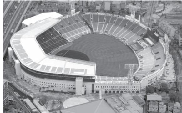
高校野球の開催を主目的として大正13年に建設された、日本で初めての本格的な野球場のリニューアル工事である。既存の構造体の大半を耐震補強し、又、銀傘を高く架け替え、客席、設備も全面入れ替える等、ほとんど全面改修されており、ベストリフォームと言っても差し支えないほどであるが、これまでと変わらぬ甲子園球場のイメージを残し、歴史と伝統を継承したいという、建築主の熱い想いを尊重し、ロングライフ部門としての授賞となった。甲子園球場と言えば、蔦で覆われた外観が印象的であったが、その下の旧外壁は打ち放しコンクリートであった。現地を視察した時の印象では、新たに構築された外壁煉瓦タイルが、旧来からのものが補修され残されたような錯覚に陥った。このように改修に当たっては、観客が抱く甲子園のイメージを大切にすることを第一に優先し、随所にそのコンセプトが展開されている。
