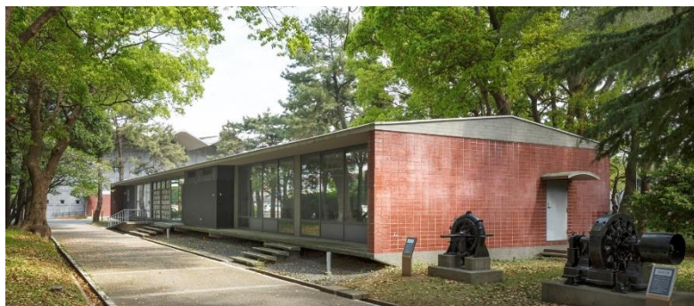
九州工業大学 鳳龍会館 ー福岡県北九州市ー
