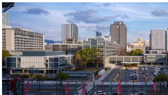
広島県庁舎本館、南館、議事堂、 北館、農林庁舎 -広島県広島市-
