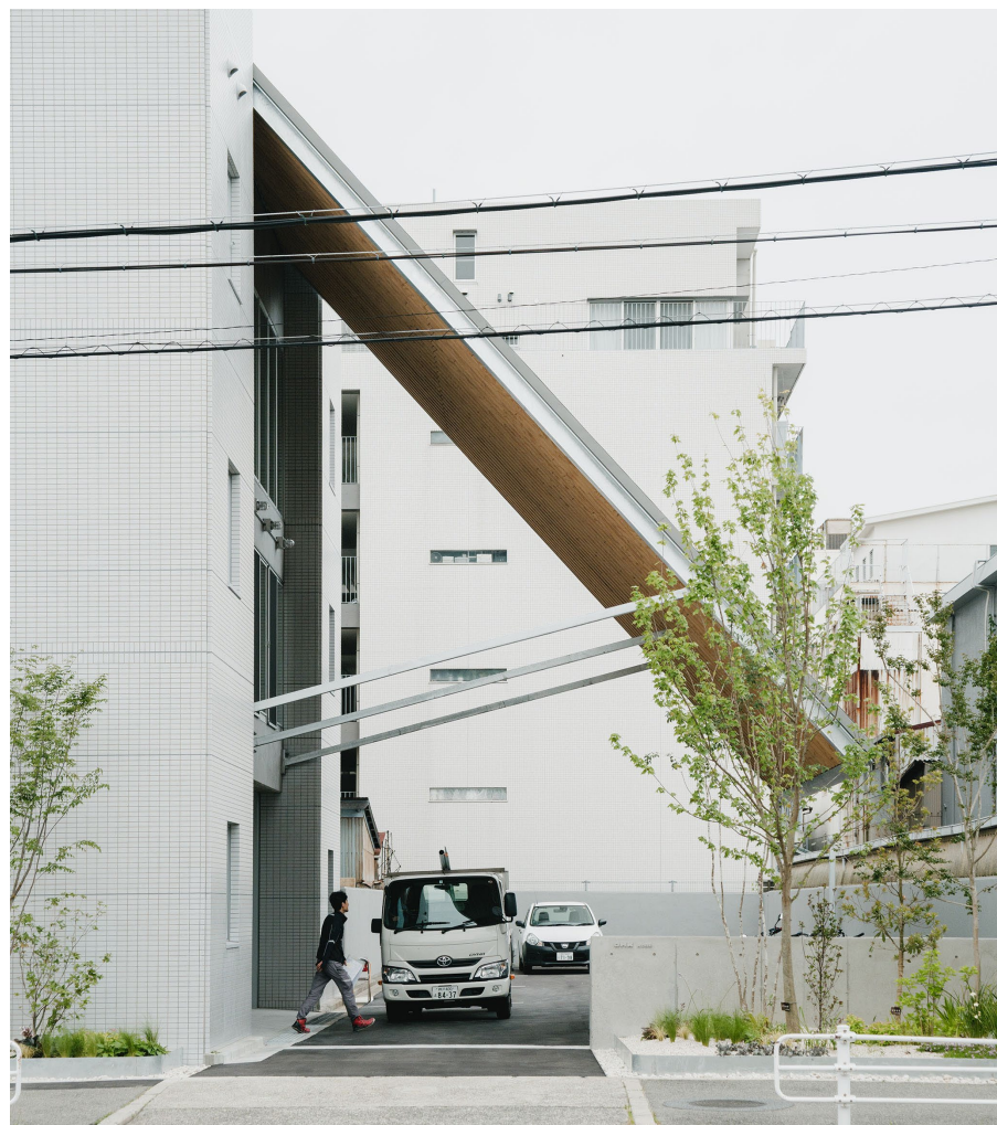
南側大庇の外観
