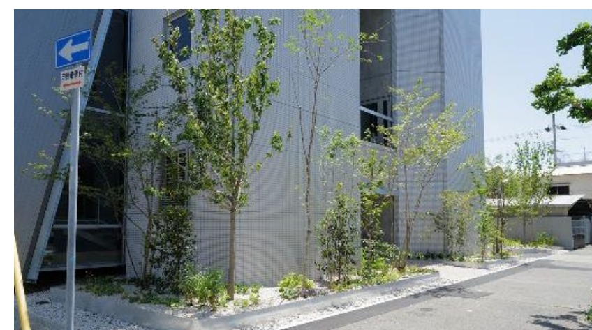
竣工直後 当初は植物は小さかった
