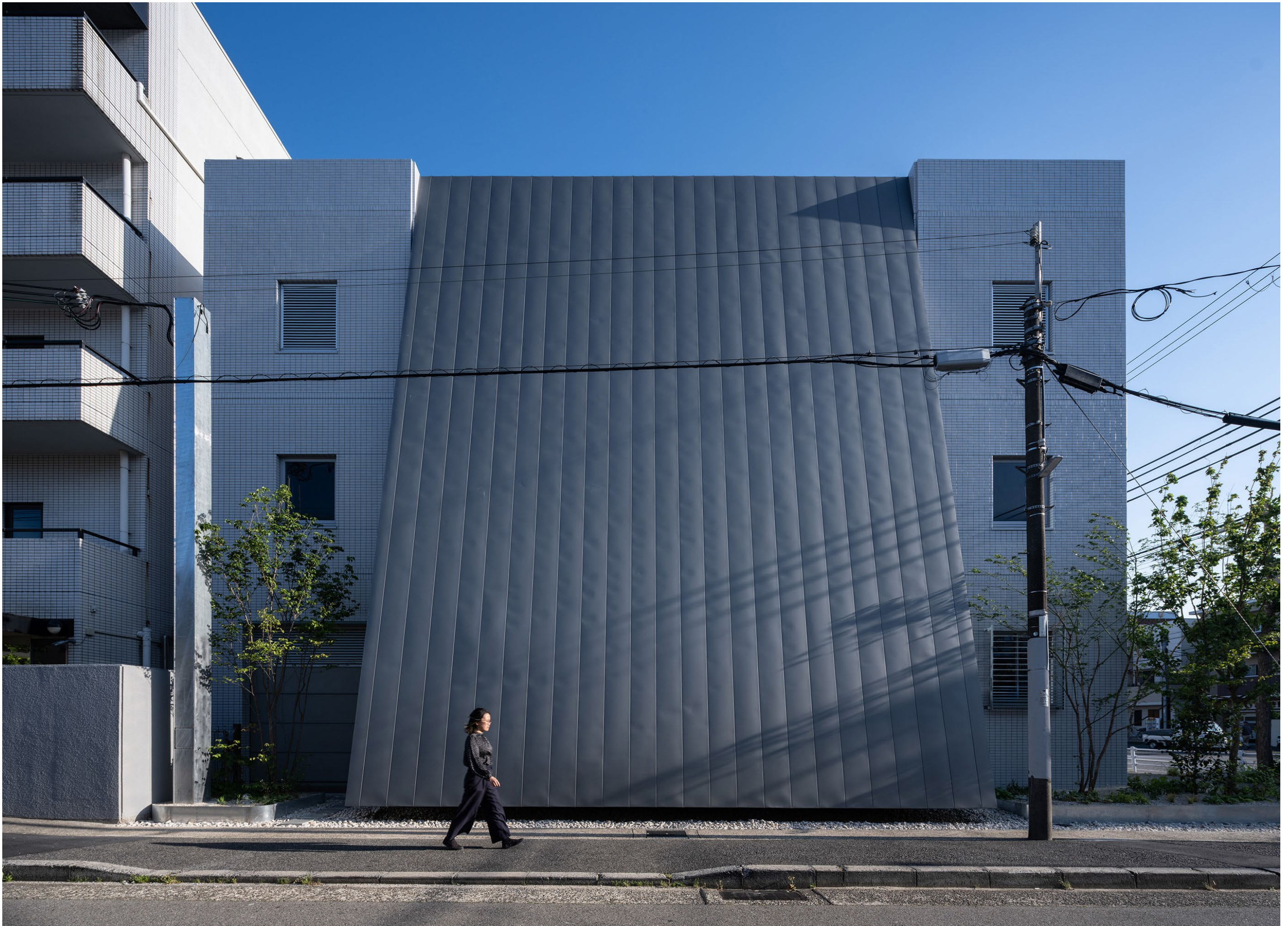
北側外観 新設屋根材は、長期間再塗装の必要がなく、経年で美化するチタン亜鉛合金
