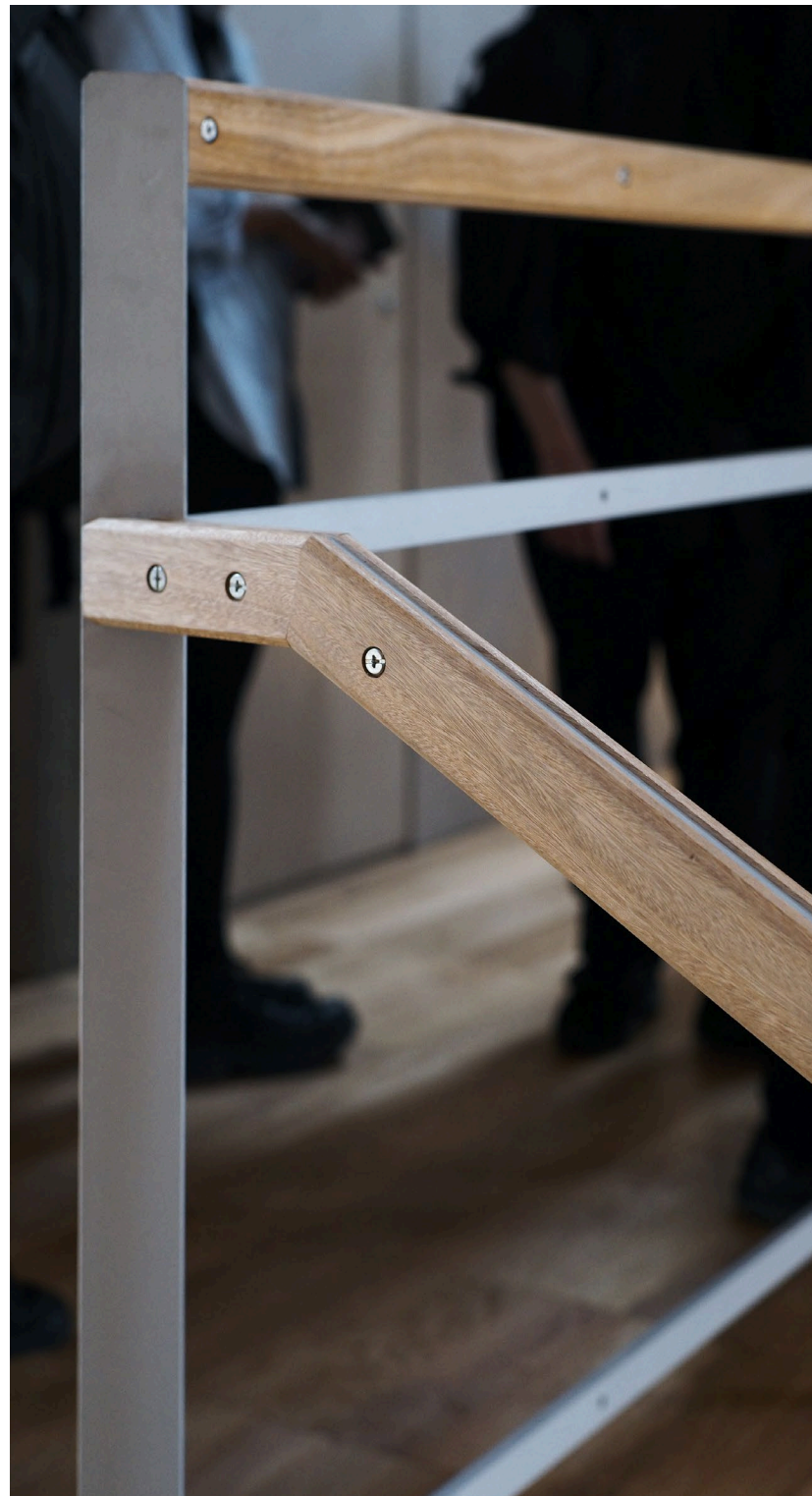
端材を活かした手すり笠木
