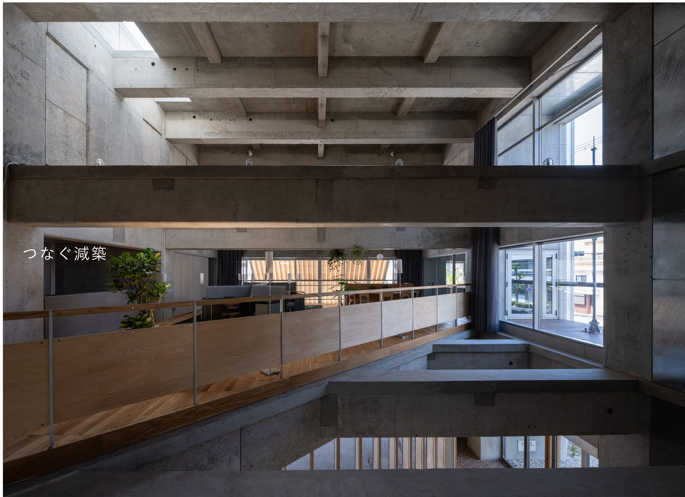
2階 既存の大梁が残る吹抜け
