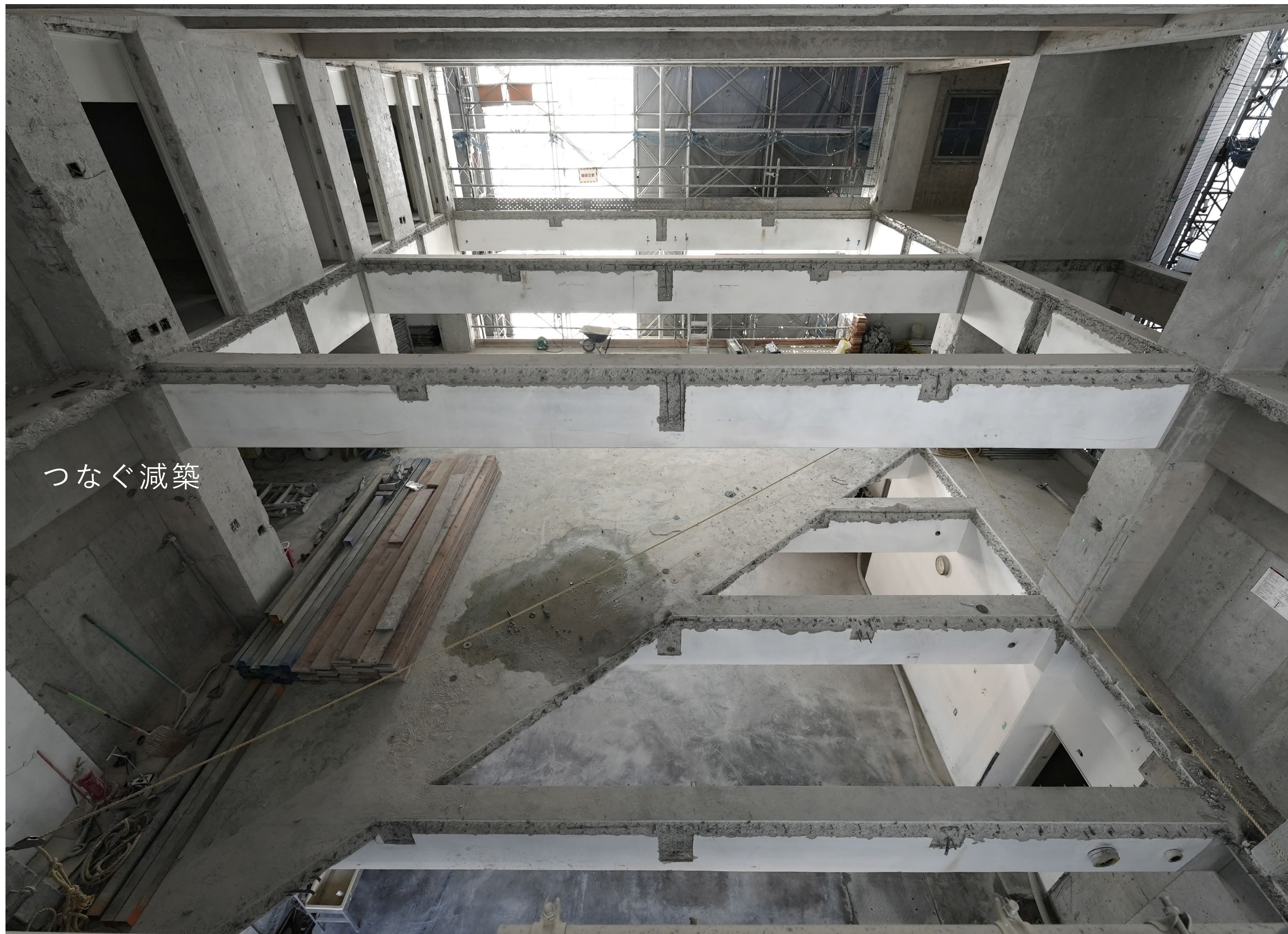
2023年10月 減築工事が終わった状況
