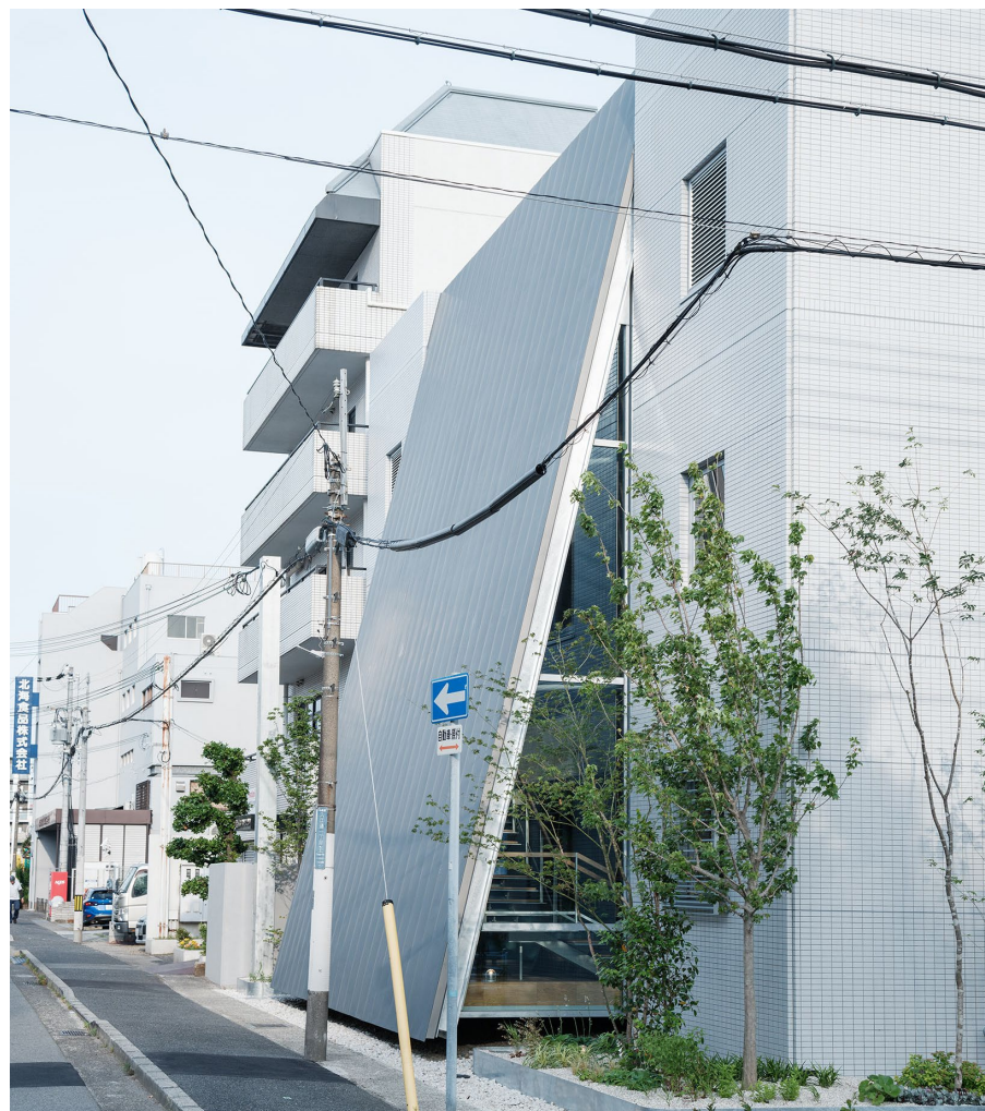
北側大庇の外観
