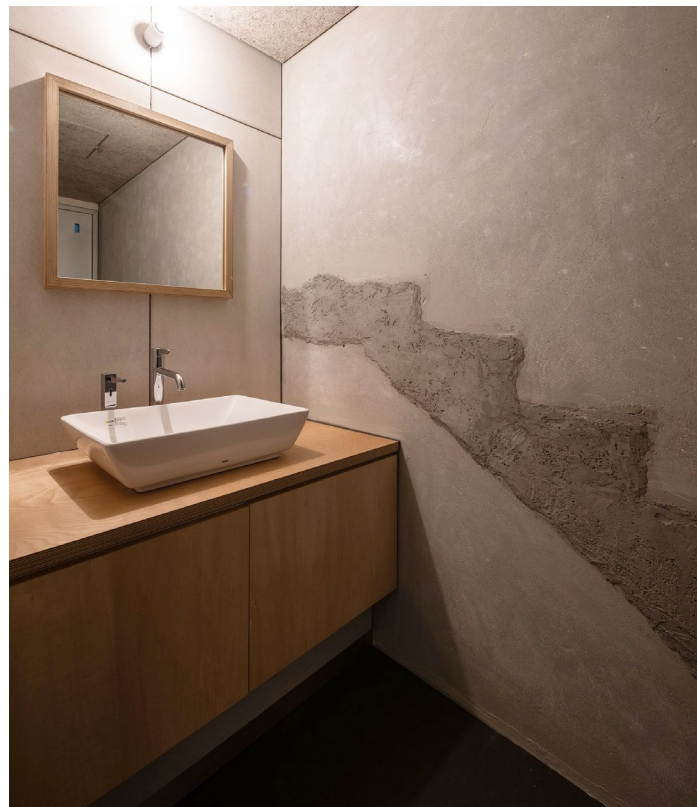
コアの壁に階段の跡が残る
