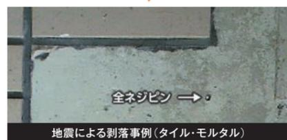
この写真は、空隙部への粉塵詰まりが樹脂拡散を妨げ、それが、強度不足に繋がり、さらに、全ネジピンは、頭部で外壁を押さえ止める効果がないため落下につながっています。(東日本大震災での事例)
