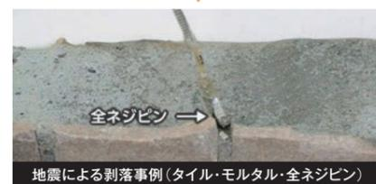
この写真は、躯体部への不完全な接着固定により、地震時に、全ネジピンがタイル部、モルタル部と共に躯体部から抜け落ちた事例です。(東日本大震災での事例)
