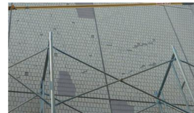
建物外壁の損傷事例【写真3】
