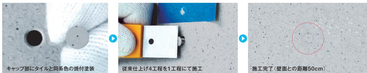
ハイブリッドピンの特長は、キャップ一体型の形状を持つことでタイル部を確実に押さえとめる効果があります。タイル陶片剥落の防止だけでなく、モルタル部・躯体部への確実な連結固定により強い地震の揺れにも対応できる安全で安心な外壁落下防止対策が図られます。
