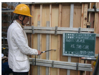
型枠の調査状況
