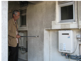
探查棒による検査
