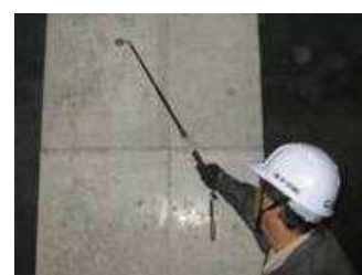
脱型直後の検査状況
