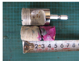
抜き取ったコアに より中性化を確認
