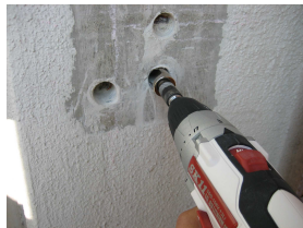
小径コアを抜き取り 鉄筋の状況を確認
