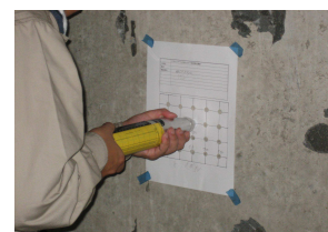
コンクリート強度を 確認
