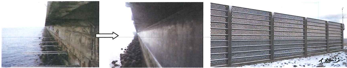
護岸リニューアル
