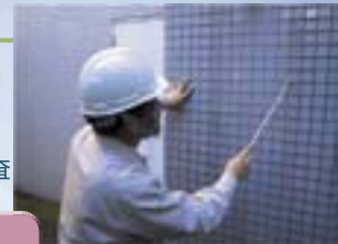
外壁打診検査
