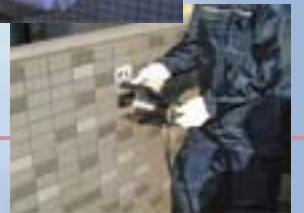
タイル接着力試験
