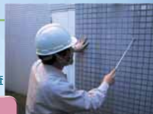
外壁打診検査
