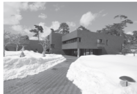
写真-2 改修後博物館外観 (前川建築設計事務所提供)
