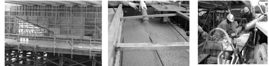
塩害を受けた橋脚の大規模な断面修復にポリマーコンクリートを使用した例
