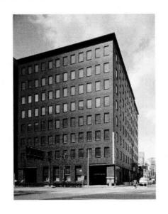
近三ビルヂングは、昭和6年(1931年)に合名会社森五商店東京支店として建築された、鉄筋コンクリート造地下1階、地上7階、延床面積4000㎡の建物で、設計は村野藤吾。彼が独立後はじめて手掛けた処女作として、「森五ビル」の名で知られている。
