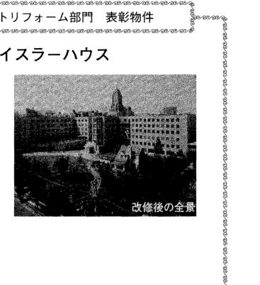
昭和初期(1933~1936年)に竣工した旧聖路加国際病院は、機能的な十字形の平面計画をベースとし、合理 的で明快な細部の意匠、アール・デコ様式による多くの装飾、ネズミやノミなどの特異な紋様を随所にちりば めた建築として多くの書物に取り上げられた。今回の「旧聖路加国際病院の保存改修及び復元」の応募内容は、 同病院の十字形の中心に位置する聖ルカ礼拝堂と、南側に位置する大部屋病棟として利用されたナイチンゲー ル病棟および東西両翼建物の一部の保存改修、保存改修建物の両側に鉄筋コンクリート造 6 階建ての病院施設 および看護大学として利用される建物の建設、さらには1933年に別敷地に建てられた鉄筋コンクリート造一部 木造・2階建ての洋風住宅建築・トイスラーハウスを移築し、記念館として復元という、大きく分けて3つか らなる。
