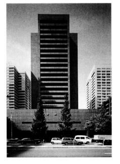
サンワ東京ビルはバレスサイドビルと共に、日建設計の代表作品である。日比谷通り側に低層の営業ゾーン、皇居内堀通り側に25階建ての業務ゾーンを配し、高層棟は4階にサービスコア、中央部に偏心して主コアが機能的に設けられ、構造・設備・防災計画上からも極めて明解且つ合理的な平面構成となっている。また、日比谷通りから皇居の緑豊かな景観を見通せるように配慮されており、計算しつくされたアーキテクトの構成の妙を窺い知ることができる。カナディアンブラックの索材の持つ質感と、重厚で格調の高い心情に訴えてくるような存在感のある造形が皇居周辺の環境と調和し、22年余りの歳月にも関わらず、見るものに新鮮な感動を与えている。
