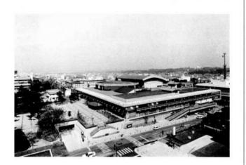
この文化会館の設計は昭和40年初頭、戦後近代建築の完成期に、隣接の奈良県庁舎の設計者でもある片山光生氏の基本設計、日建設計の実施設計・監理によって行われた。当時、風致地区内の近代建築について賛否両論の景観論争があったというが、大路の松並木から十分後退させた配置計画、もはや様式として定着した小幅板型枠によるコンクリート軸組みの構成、意を尽くした構造体のディテール、水平な低層屋根と塔屋の曲線の対比など、時を経て奈良の景観になったという当事者の主張が妥当と思われる建築である。
