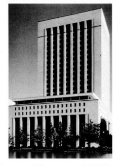
DNタワー21は、丸の内の一街区の中の、昭和初期に五年の年月をおいて建設された二つの事務所建築を、一つの大きなオフィスビルに再構築するという、極めて意欲的な試みの計画である。二つの建物は、様式は異なるが、同じ設計者による本石張りのファサードをもち、それが長い間、街並みの構成要素として親しまれてきた。その街路に面した部分の表情をできる限り保ったまま、大きな床面積の高層事務所ビルを生み出すため、完全保存、部分保存、解体再構築という、異なる手法が同時に採用されている。完成した建築は、従来の街路と軒の高さの好ましい関係を保ちながらも、近代的な執務空間や豊かな共用空間、そして内部化された公開スペースを生み出している。これは、歴史的建造物の保存と再生に関する、様々な手法の博物館といってもよいであろう。
