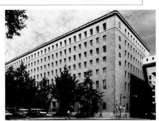
日本生命保険相互会社は、明治22年の創業以来、大阪御堂筋にレンガ造の本社社屋を構えていたが、昭和初期の道路拡幅を契機に、御堂筋によりふさわしい美観と格調の高さを備えた建物として、長谷部竹腰建築設計事務所(日建設計の前身)に設計を依頼し、昭和13年に当本館ビルの北半分の部分(第一期)を竣工させた。その後、日建設計にその設計は引き継がれ、昭和37年に南半分の建設(第二期)を行うとともに、北半分の改修と設備の更新を加えることで、昭和38年に現在の一体化した形に完成された。
