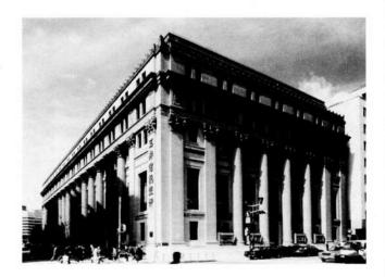
三井本館は、旧三井本館が関東大震災で内部が焼失したあと、当時の日本の経済を代表するグループのひとつである三井財閥の本拠に相応しいものを建設しようということで、近代建築の先進国であるアメリカの設計と施工により重厚壮麗なデザインと耐震耐火性に優れた建築を指向して計画された。建設資材も最高の品質のものを広く世界に求めるという方針のもとにすすめられ、大正15年(1926年)に着工し昭和4年(1929年)に竣工している。こうした東京の経済の中心地区のひとつである日本橋を象徴する建築として成立し、隣接する日銀本店と共に日本橋の顔として多くの人に親しまれ、現在に至っている。三井グループ主要各社の本拠として数多くの逸話も残っているように、昭和の歴史を刻んできている名建築である。
