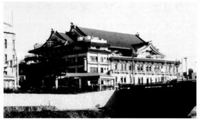
昭和4年(1929年)に由緒ある櫓を備えた桃山風破風造りの豪華な劇場として竣工した南座が、平成3年に京都の景観にとけこんだ外観はそのままに内部を全面改修し、最新設備の近代劇場として再生された。舞台と客席が近く、役者が舞台に立つと、観客に包み込まれる感じを受ける南座が60年振りの大改修を行い、しかも観客が一見しただけでは、どこが変わったのか分からないほど以前の雰囲気を残し再生された。改修は、外観・内部全般・設備・舞台機構と全面的に行われた。外観が新築当初の真新しい姿にもどされ、内部は新法規に則った客の安全対策と設備の近代化による快適追求・機能強化がなされた。エントランスホールやロビーにある精巧な金物・照明器具などは新調する以上に手間と費用をかけ再利用されている。復旧した灯具の電装品はすべて取り替え、ワット数を増し、灯体の金物は錆を落とし、漆塗り金箔押しするなどし元の位置にもどされている。
