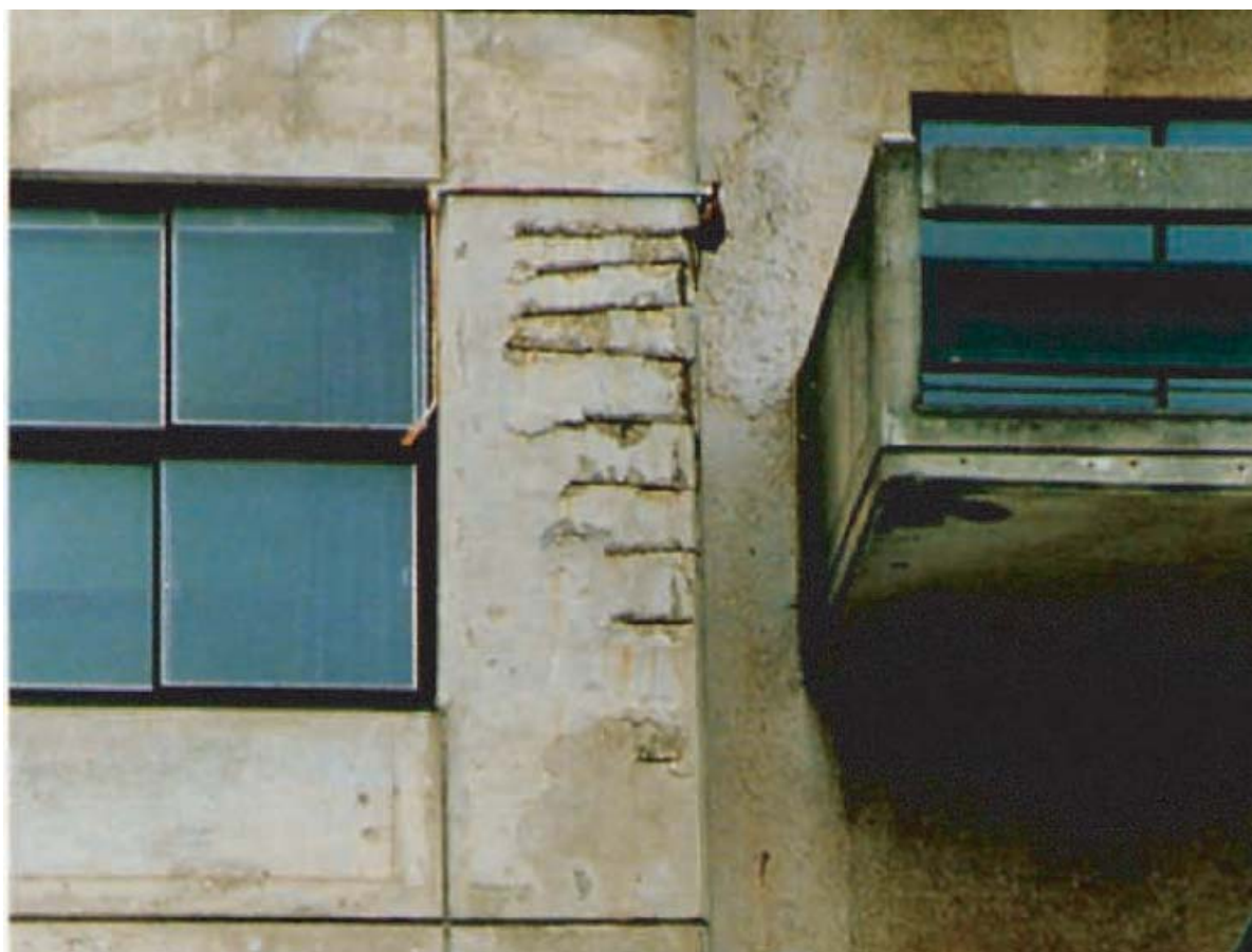
中性化による鉄筋の腐食
