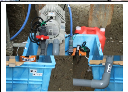
給水・吸引設備
