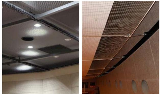
図-15 (左) 天井に鉄骨を組みネット設置
