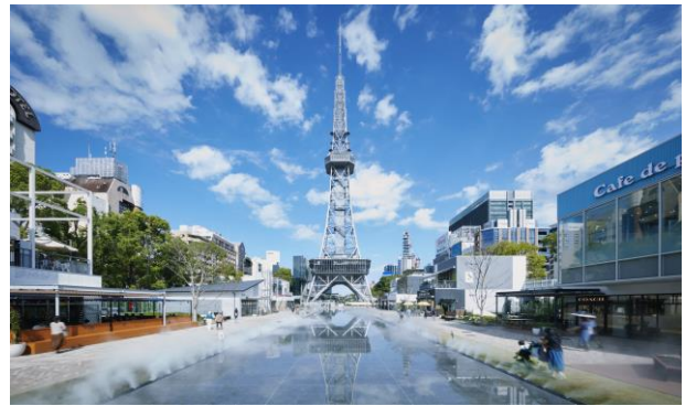
中部電力 MIRAI TOWER (名古屋テレビ塔) —愛知県名古屋市—
