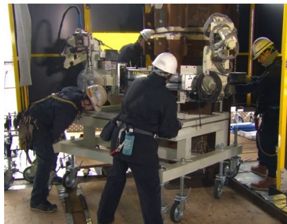
専用台車による設置状況
