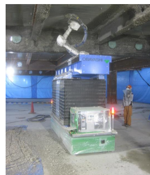
ロボット施工
