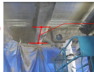
建設技能工による吹付け
