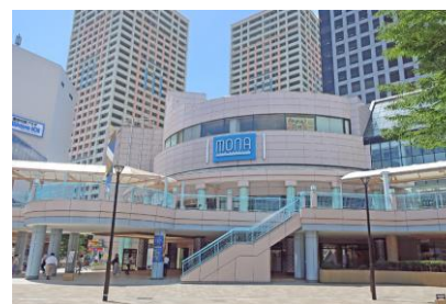
千葉県浦安市商業ビル 6階建
