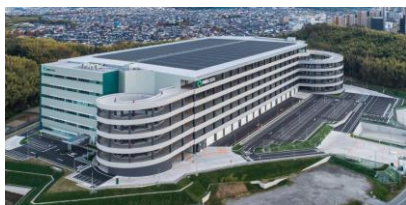
京都府京田辺市物流倉庫
