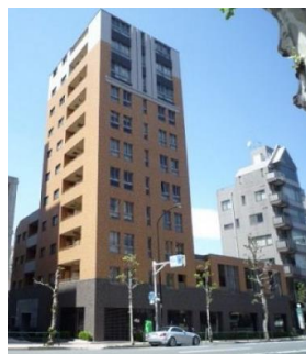
港区マンション 12階／53戸
