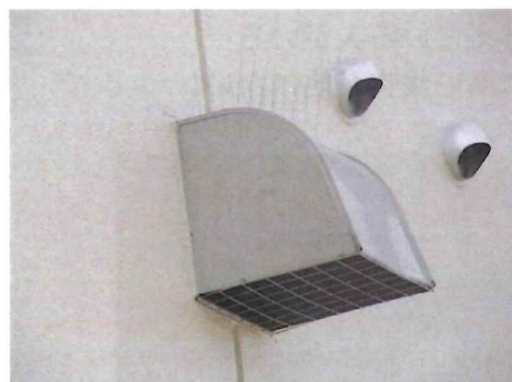
換気ダクト上部へ設置
