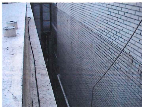
建物間へ設置
