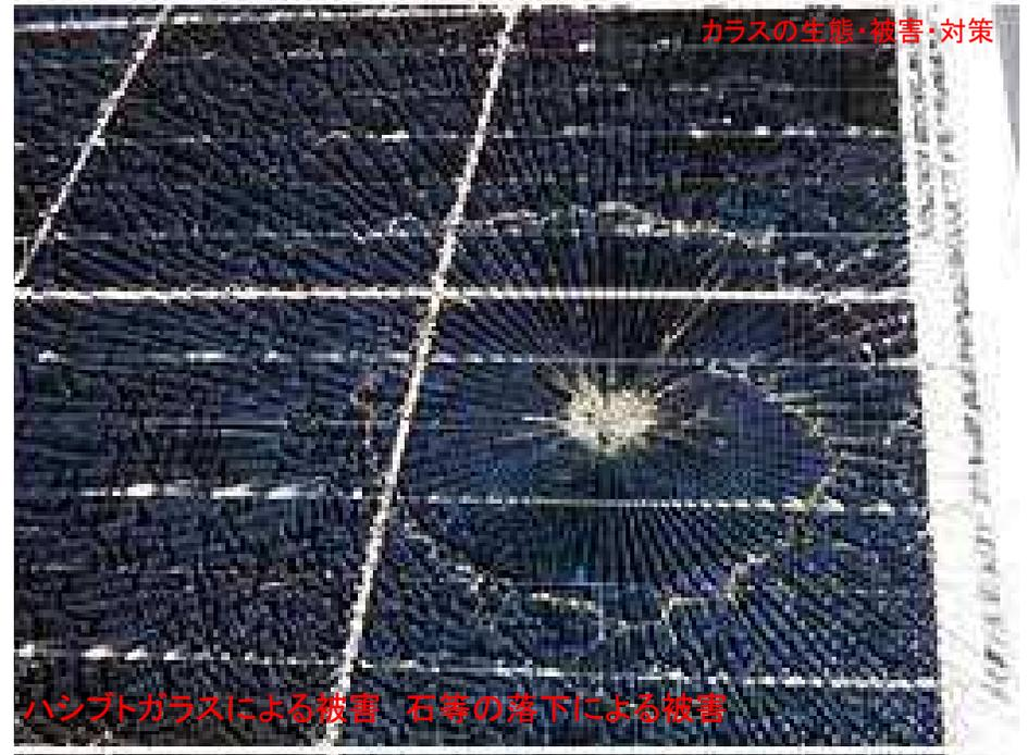
ハシブトガラスによる被害 石等の落下による被害
