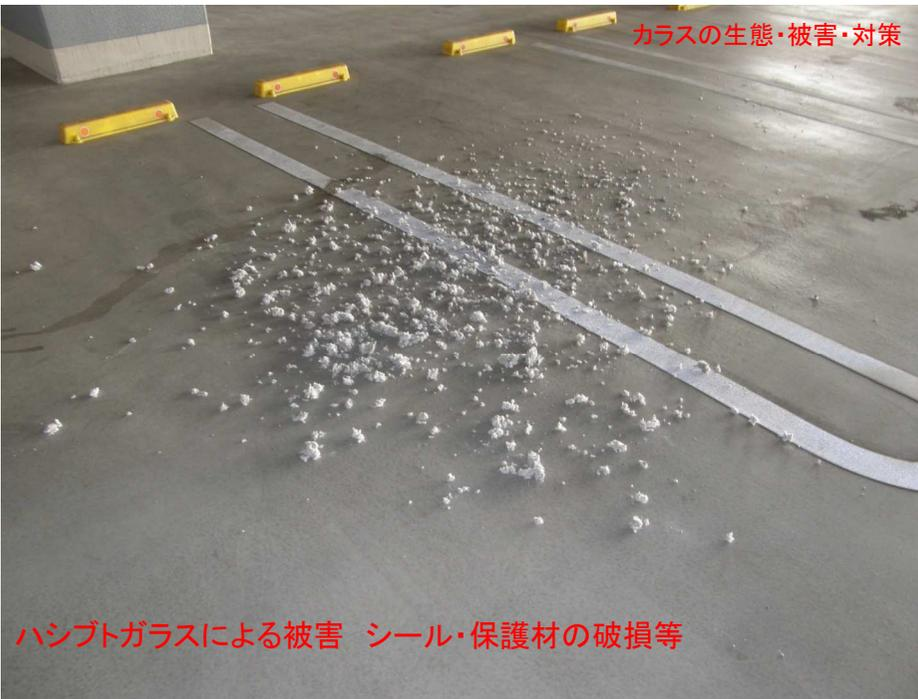
ハシブトガラスによる被害 シール・保護材の破損等
