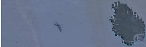
ハシブトガラスによる被害 シール・保護材の破損等
