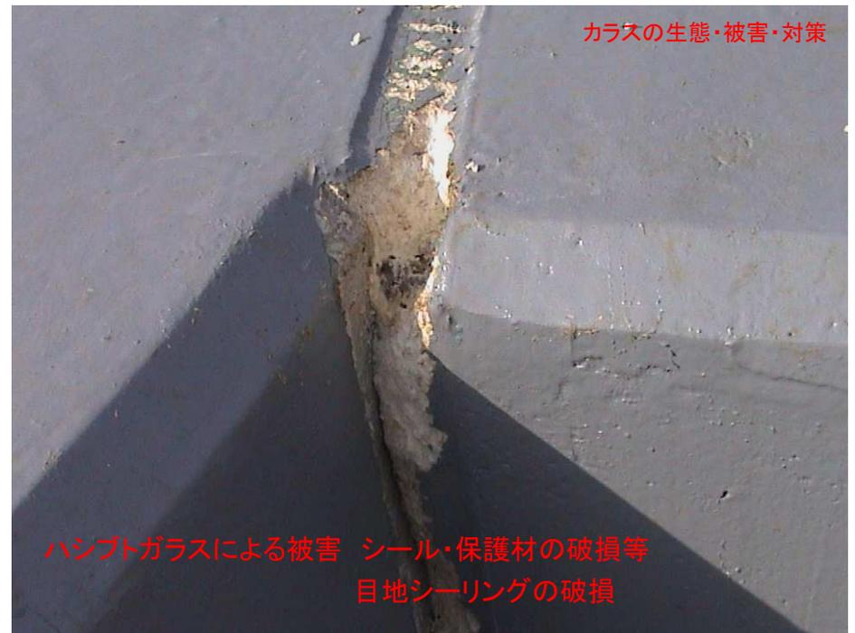
ハシブトガラスによる被害 シール・保護材の破損等
