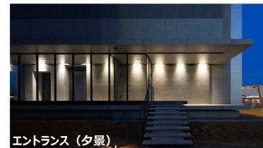
エントランス (夕景)
