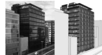
加賀電子本社ビル (左:実写/右: BIM モデル)
