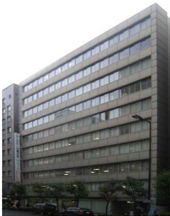
(Aビル改修前)
