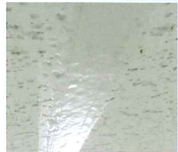
天井面に塗られた塗料
