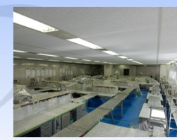
塗装工事了（足場撤去前）
