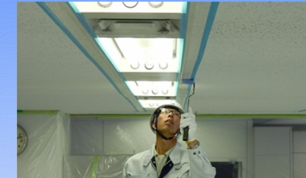
ローラーによる上塗り
